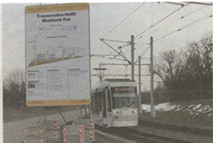
Es geht los: In Tinz haben die Vorarbeiten für das Stadtbahnprojekt nach Bieblach-Ost begonnen. (Foto: SWG)
